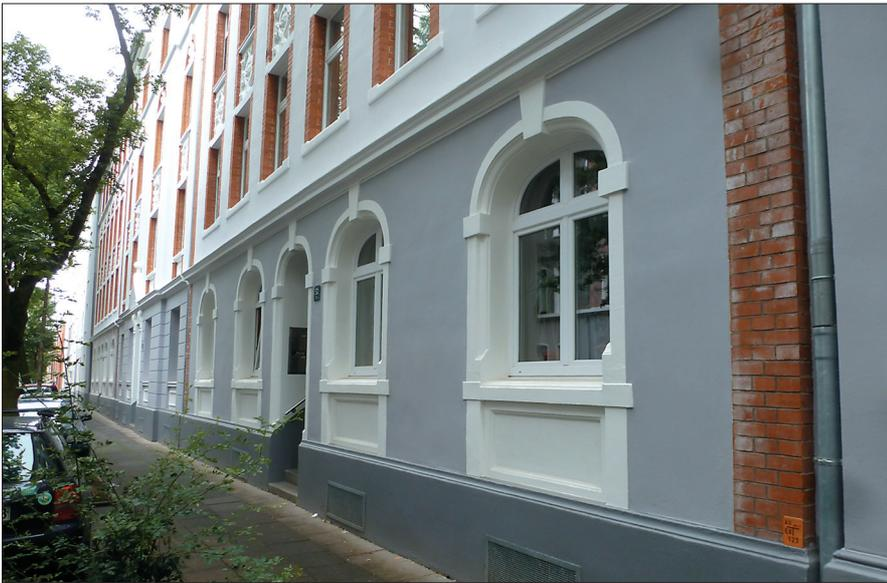
Über 6.500 m<sup>2</sup> Wand- und Sockelfläche bis zu 4 m Höhe wurden mit „Scheidel HydroPur ‚Silan Schutzlack 2K“ geschützt. Die Schutzschicht ist matt und nur bei extremem Streiflicht wahrnehmbar.
