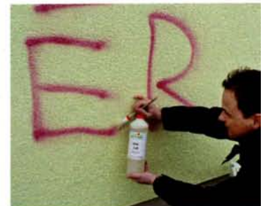
Anlegen einer Testfläche, z. B. mit m.a.c.s.® Soft Graffiti-entferner auf mit »Eposilan« geschützter Putzfläche
