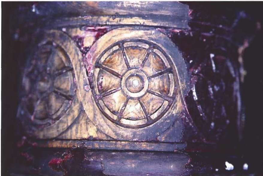
Mithilfe von dichlormethanfreien Abbeizern lassen sich alte Farbschichten auch auf empfindlichen Untergründen zuverlässig entfernen.
