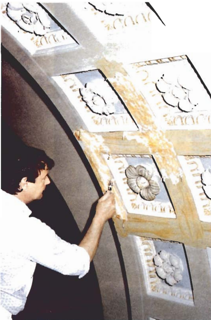
Malermeister Haupt überprüft die Abbeizarbeiten an der Kassettendecke.
