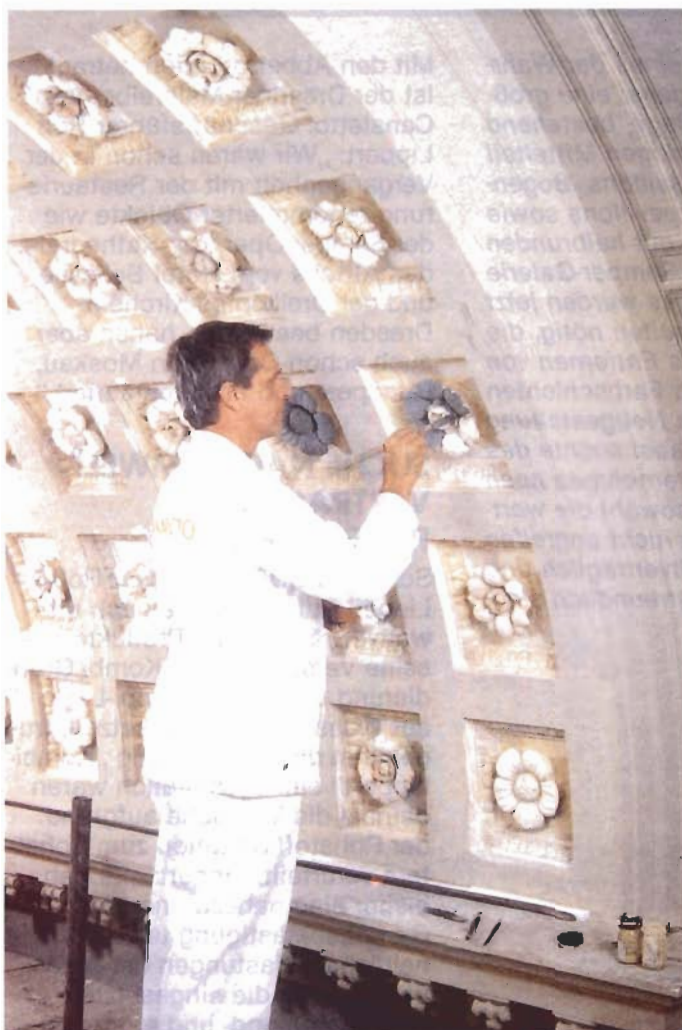
Die ursprüngliche Farbigkeit der Galerie-Rosetten wird wiederhergestellt. (Fotos: Scheidel)
