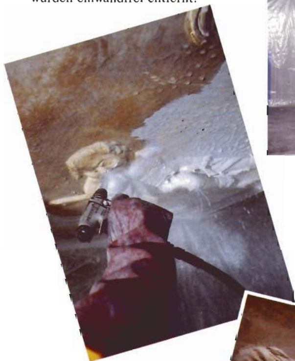
Nach Einwirken des Abbeizers kann der Stuckengel mit dem Airless-Druckstrahl von der alten Dispersionsfarbe befreit werden.
