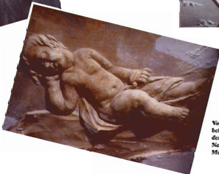
Nach Einwirken des Abbeizers kann der Stuckengel mit dem Airless-Druckstrahl von der alten Dispersionsfarbe befreit werden.
