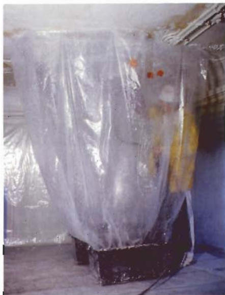
Der Folien-»Käfig« ermöglicht das Abspritzen der Decke mit einem Wasserstrahl über ein Airless-Gerät. Unten die Wanne zum Auffangen des Wassers.
