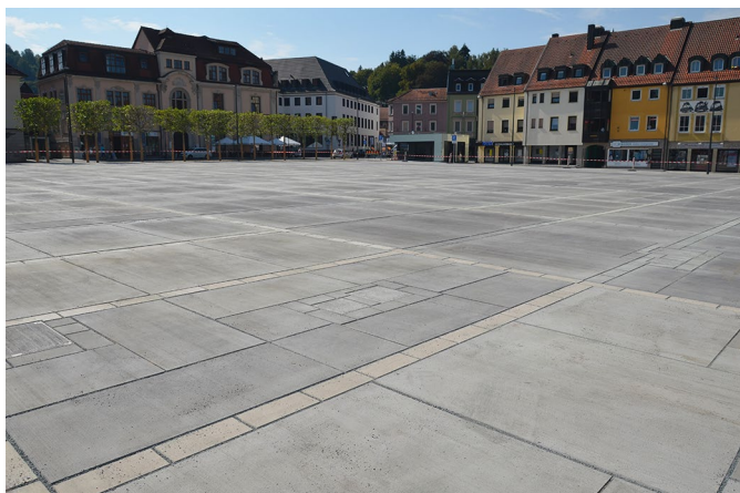
Bild 1 Neu gestalteter Zentralparkplatz und Festplatz aus Betonfertigteilen in Kulmbach mit Oberflächenschutz Scheidel HydroGraff®.
