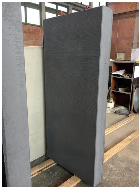
**Bild 3** Betonfertigteile – im Fertigungsprozess imprägniert mit Scheidel-HydroGraff CC- OS-A AGS Crème
