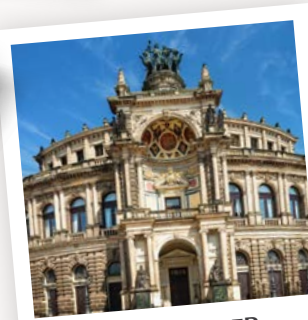
SEMPER-OPER in Dresden (Galerie, Fassade)
