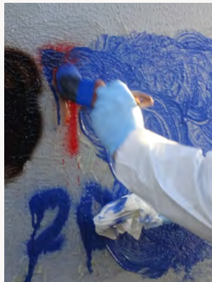
Gelöstes Graffiti stets verreiben. Dies führt i.d.R. zu besseren Reinigungsergebnissen.
