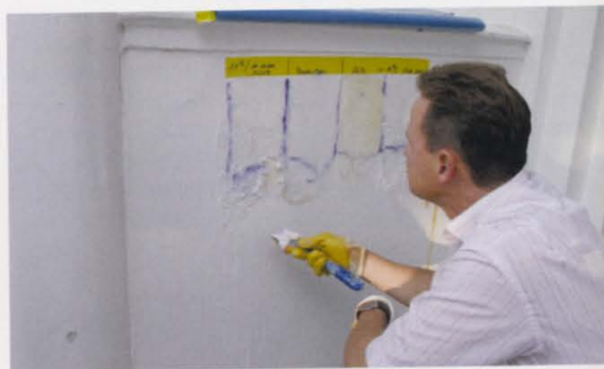
Testflächen zeigen die Wirkung unterschiedlicher Abbeizprodukte.
