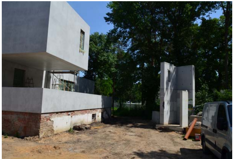
Baustellenansicht mit Testwand
